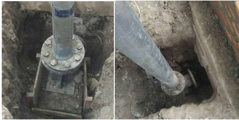
รูปที่ 79 งานท่อจ่ายน้ำหอดึงสูงและช่องออตินเปิด
