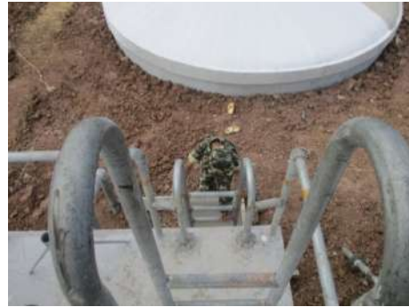
รูปที่ 75 งานติดตั้งบันได ขึ้น-ลง ถังกรองน้ำผิวดิน
