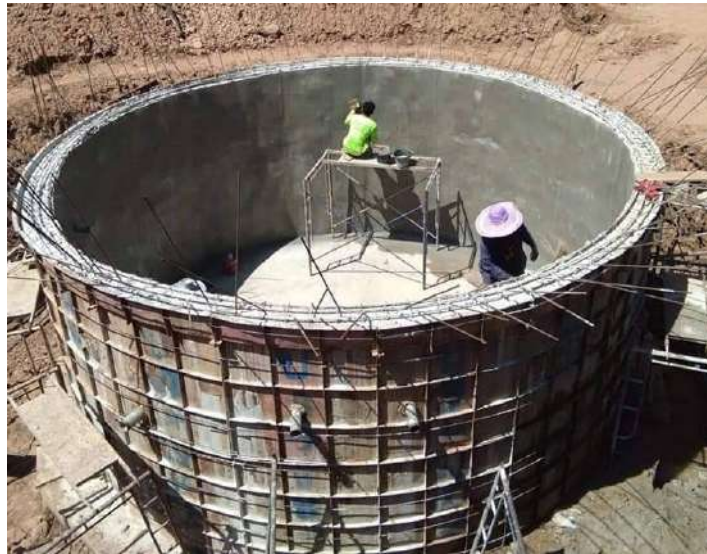
รูปที่ 73 งานคอนกรีตภายในส่วนที่สัมผัสน้ำ ฉาบสารกันซึม ชนิดซีเมนต์เบส
