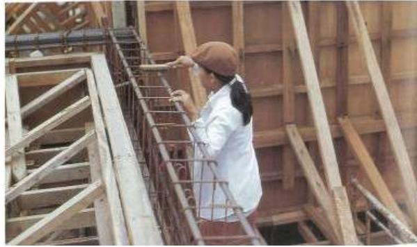
รูปที่ 24 การใช้แปรงลวดขัดทำความสะอาดเหล็กเสริม กรณีเกิดสนิมเล็กน้อยไม่กินเนื้อเหล็ก
