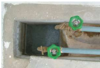
รูปที่ 76 จุดที่ผสมสารละลายสารส้ม และปูนขาว ไฮดรอลิกจัม (HYDRAULIC JUMP)
