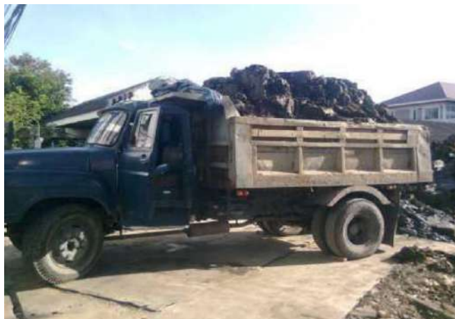
รูปที่ 3 การขนย้ายวัสดุที่ไม่ต้องการ ออกจากบริเวณที่ทำการก่อสร้าง
