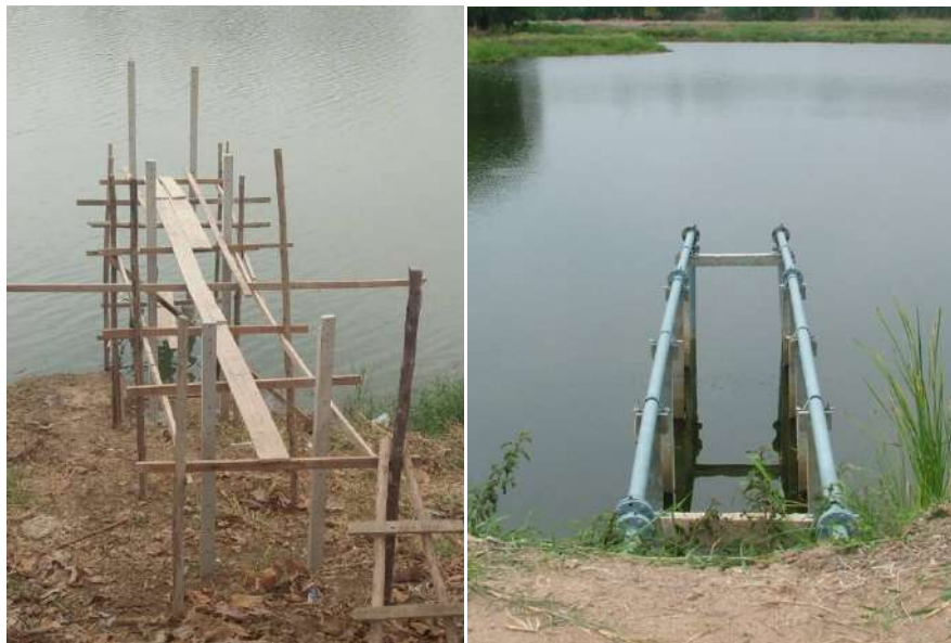
รูปที่ 78 งานท่อสูบน้ำดิบตรวจสอบระดับน้ำ ขึ้น - ลง เพื่อกำหนดระดับท่อทางดูด
