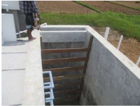
รูปที่ 75 งานติดตั้งบันได ขึ้น-ลง ถังกรองน้ำผิวดิน
