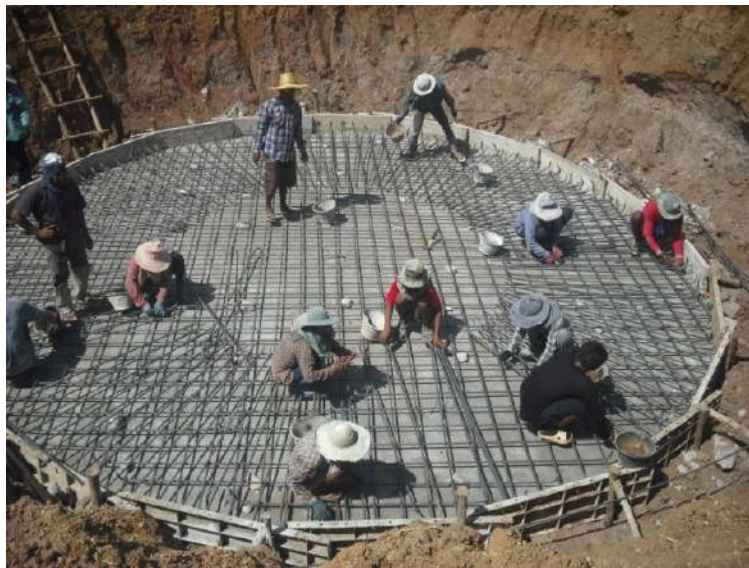
รูปที่ 25 การวางเหล็กเสริมฐานรากถึงน้ำใส
